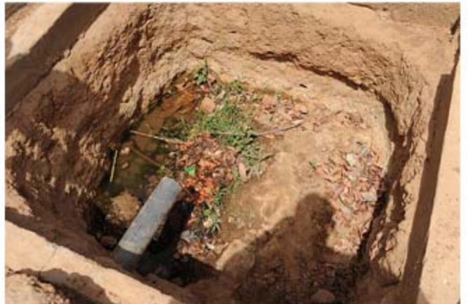
La poca acqua che si vede nel serbatoio di scolo è stata pompata da noi durante l'ispezione.
