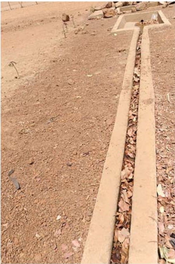
Foglie nel canale di raccordo tra pozzo e abbeveratoio
